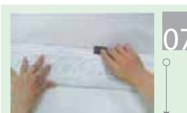
Шаг 7. Не забудьте стереть излишки остатков клея с помощью влажной губки
