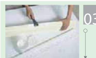
Шаг 3. Нанесите клей монтажный по краям обратной стороны карниза, а также на поверхность, которую будете клеить
