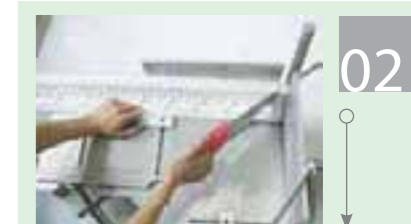
Шаг 2. Используя стусло и мелкозубчатую ножовку, отрежьте карниз по полученным отметкам
