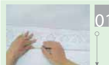
Шаг 1. Сделайте отметки на карнизах и потолке для соединения углов
